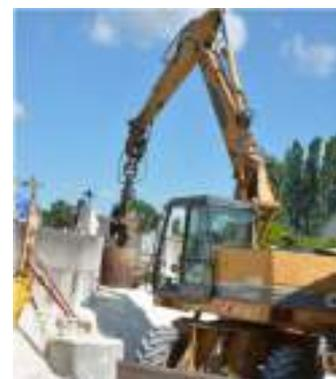
Le 03/06/2020: pose de 6 pieux en béton pour consolider la partie effondrée
